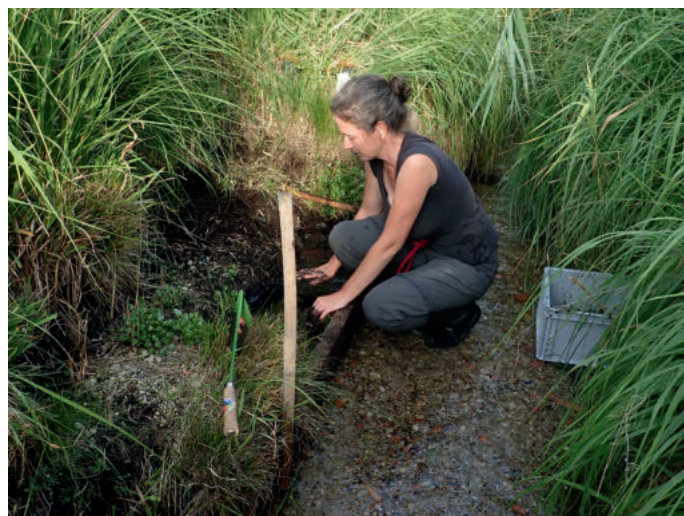
Abb. 2: I. Drozdowski beim Einbau der Bretter als Erosionsschutz (Bereich wie Bild 1). Foto: A. Mrkvicka
